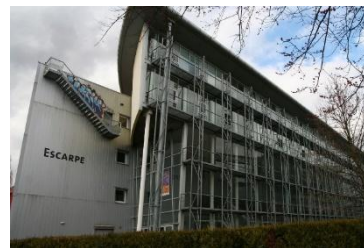
Escarpe 11 rue du Maréchal Juin 67000 Strasbourg
